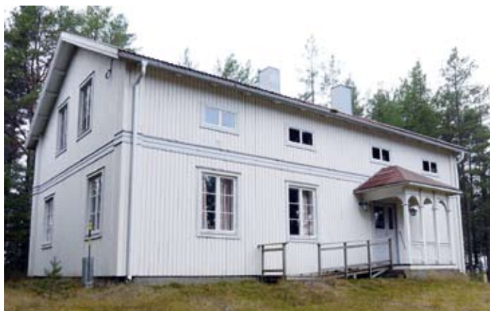
1990 fick bönhuset sitt nuvarande utseende i samband med tilläggsisolering och ny brädfodring.
